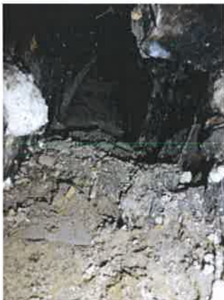
CONDUIT CHEMINES P1080225
