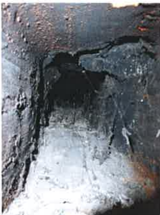
Conduit cheminée sous fenêtre
