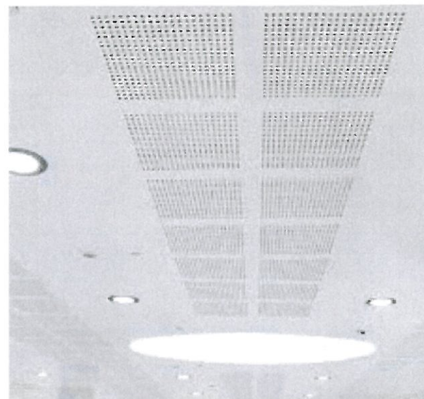
faux plafond dalles démontables
