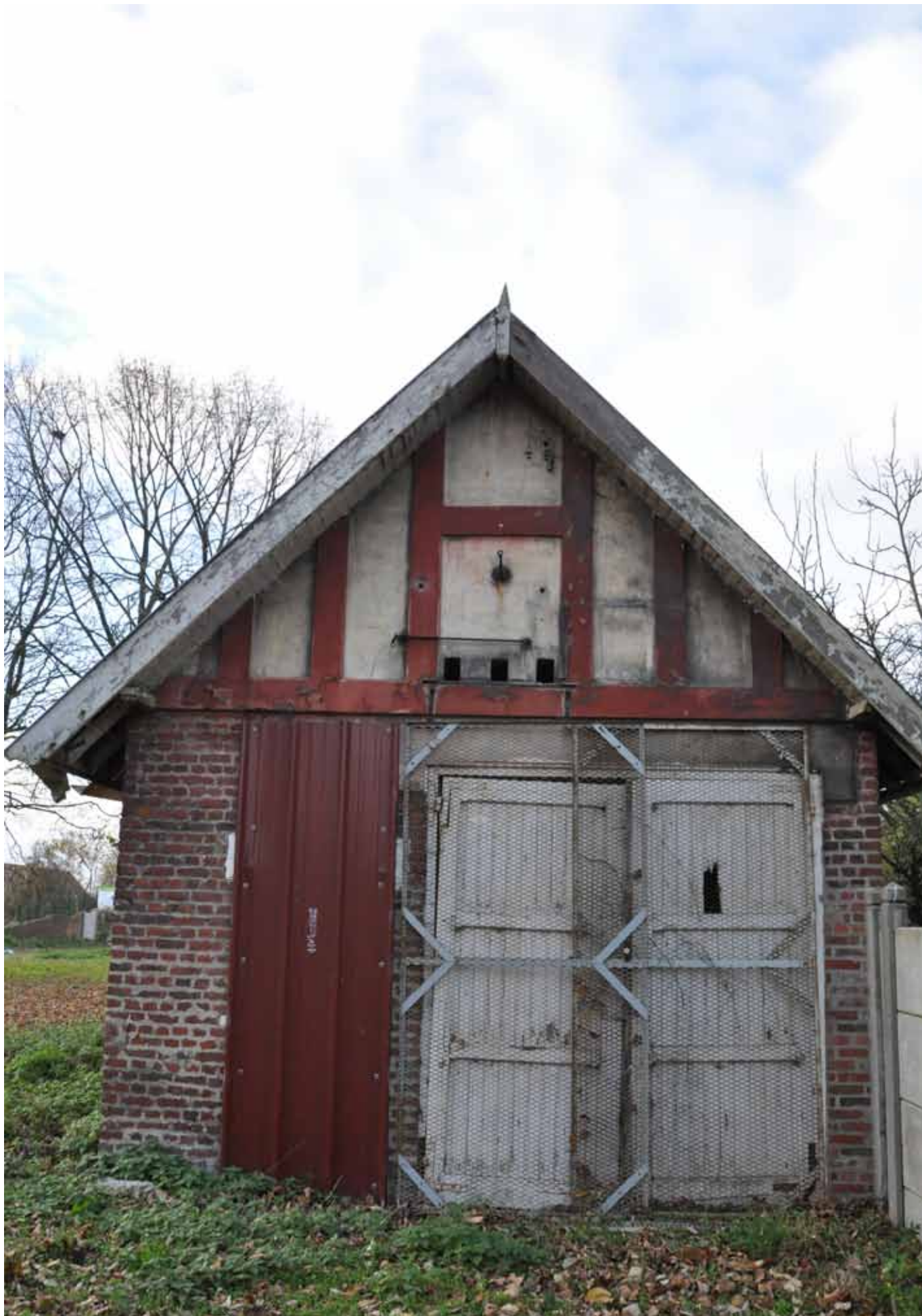
DÉPENDANCE EXTÉRIURE (CONSTRUCTION INDÉPENDANTE)
