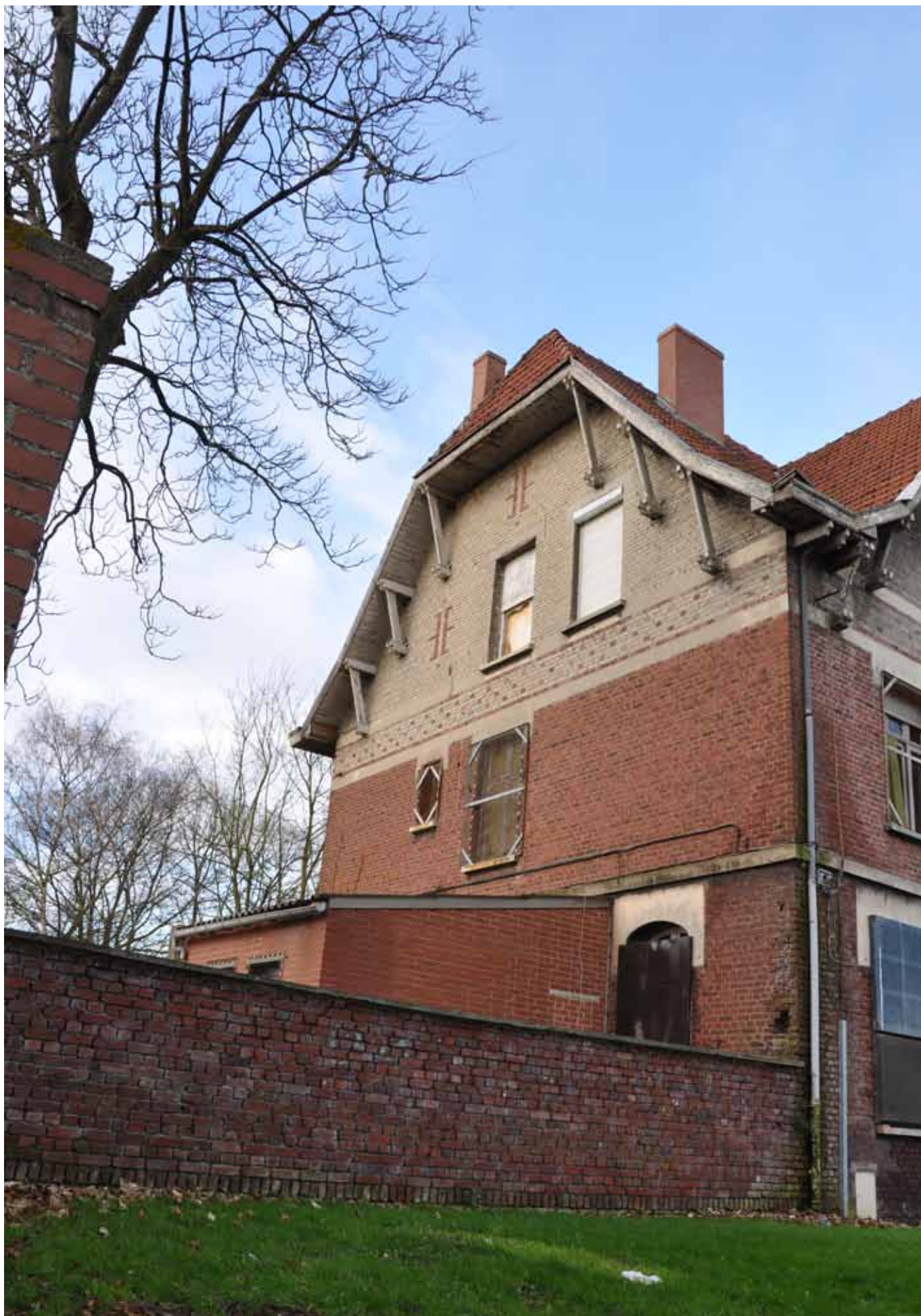
MUR SÉPARANT JARDIN & RUE
