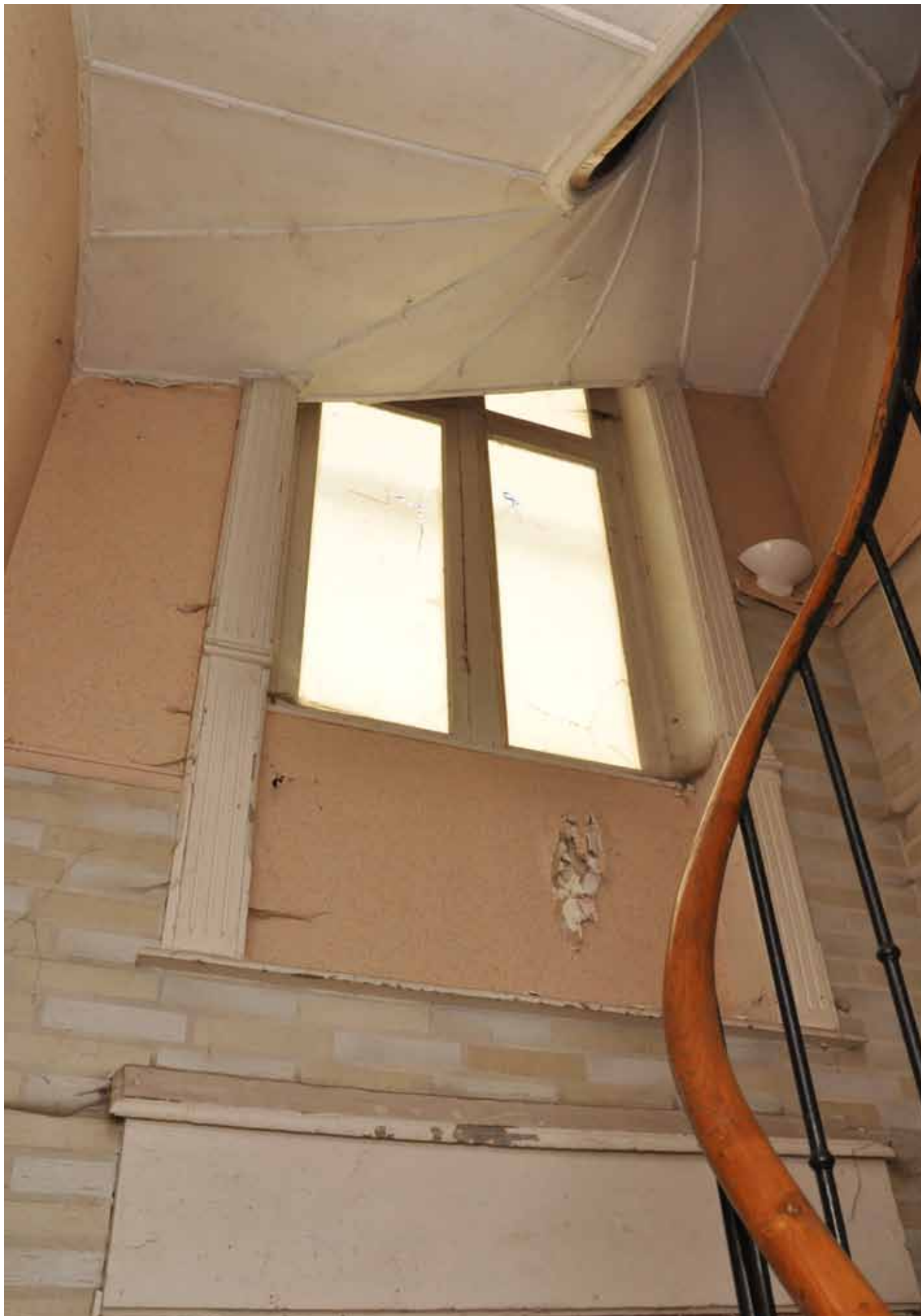
OUVERTURE TRAVERSANT L'ESCALIER
