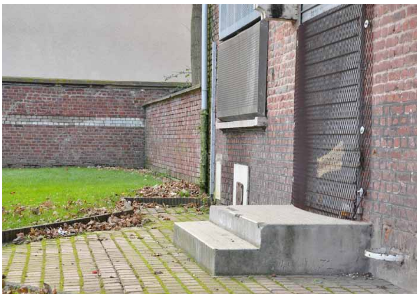
BALCON & ESCALIER EN FAÇADE
