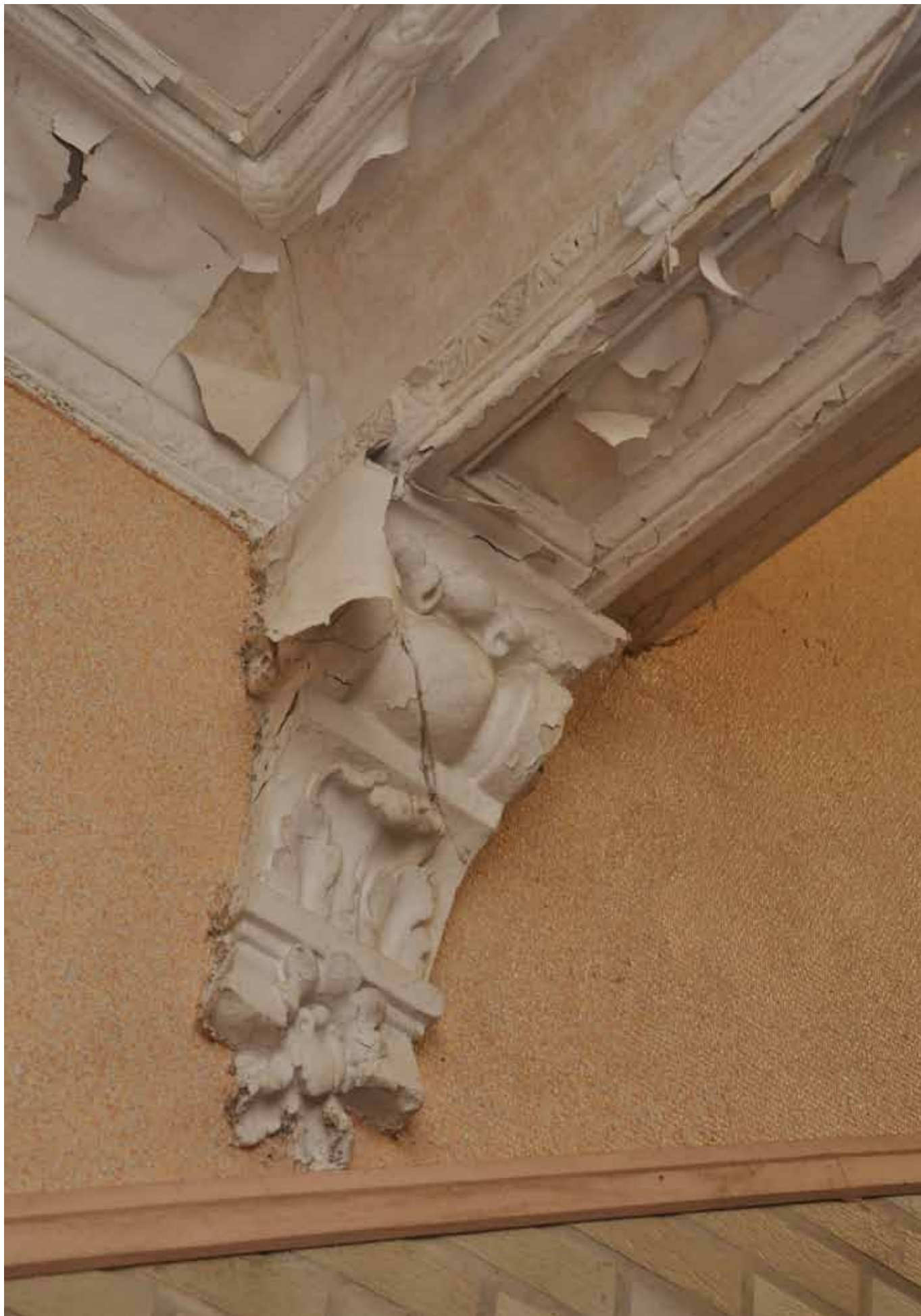
MOULURES SOUS ESCALIER
