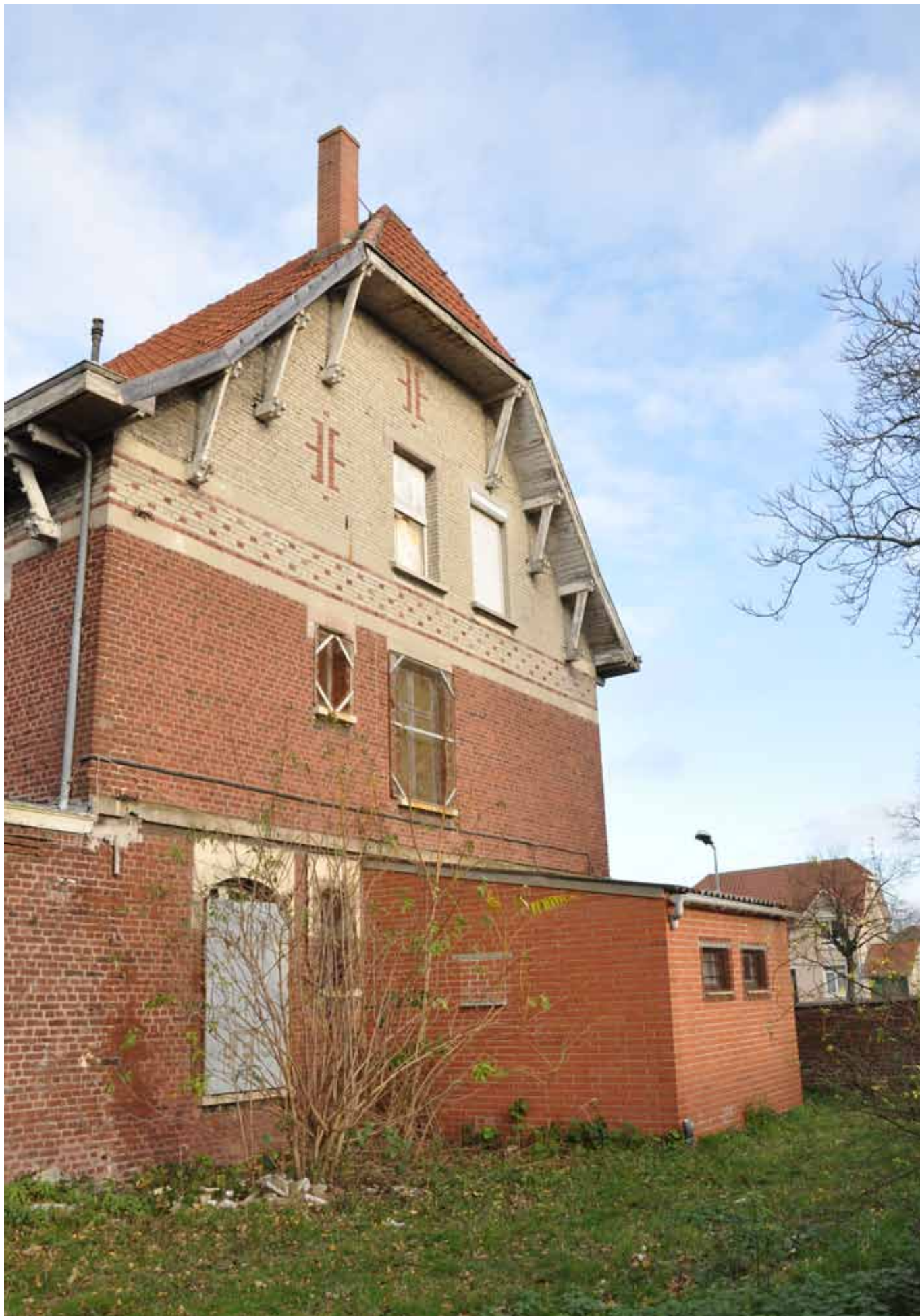
ARRIÈRE / FAÇADE SUD
