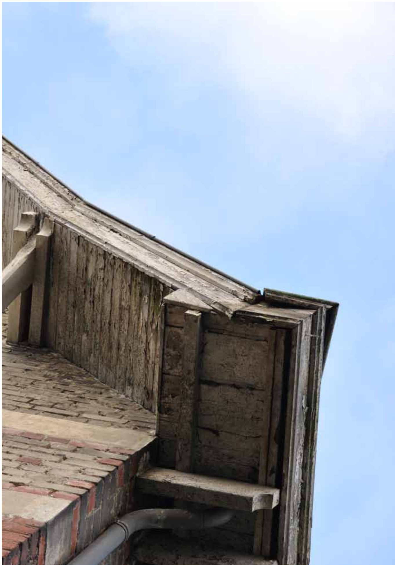
ÉTAT DES BOISERIES EXTÉRIEURES
