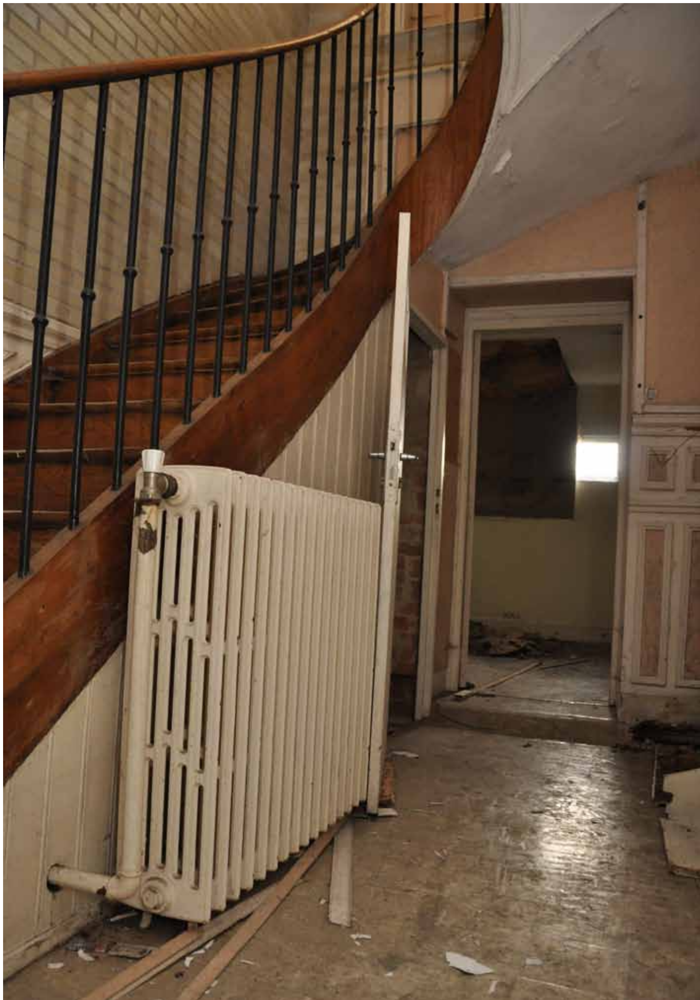
ESCALIER / ACCÈS CAVE
